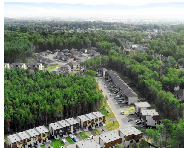
Ensemble résidentiel Jardin du Coteau qui préserve une grande proportion d'espaces boisés rendus accessibles par un réseau de sentiers, Mascouche Source : Jardin du Coteau
