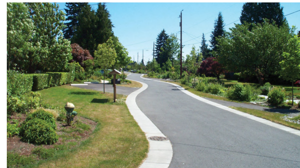
Tracé sinueux et aménagements favorables aux déplacements piétons, Seattle, États-Unis
