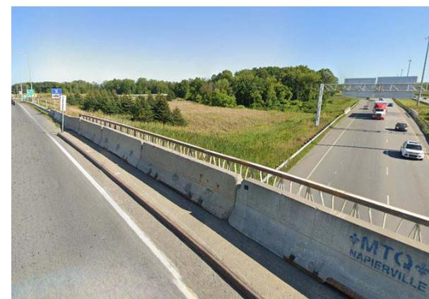
Discontinuité du réseau actif, obstruction du trottoir et absence de garde-corps sur le viaduc surplombant l'autoroute 30
