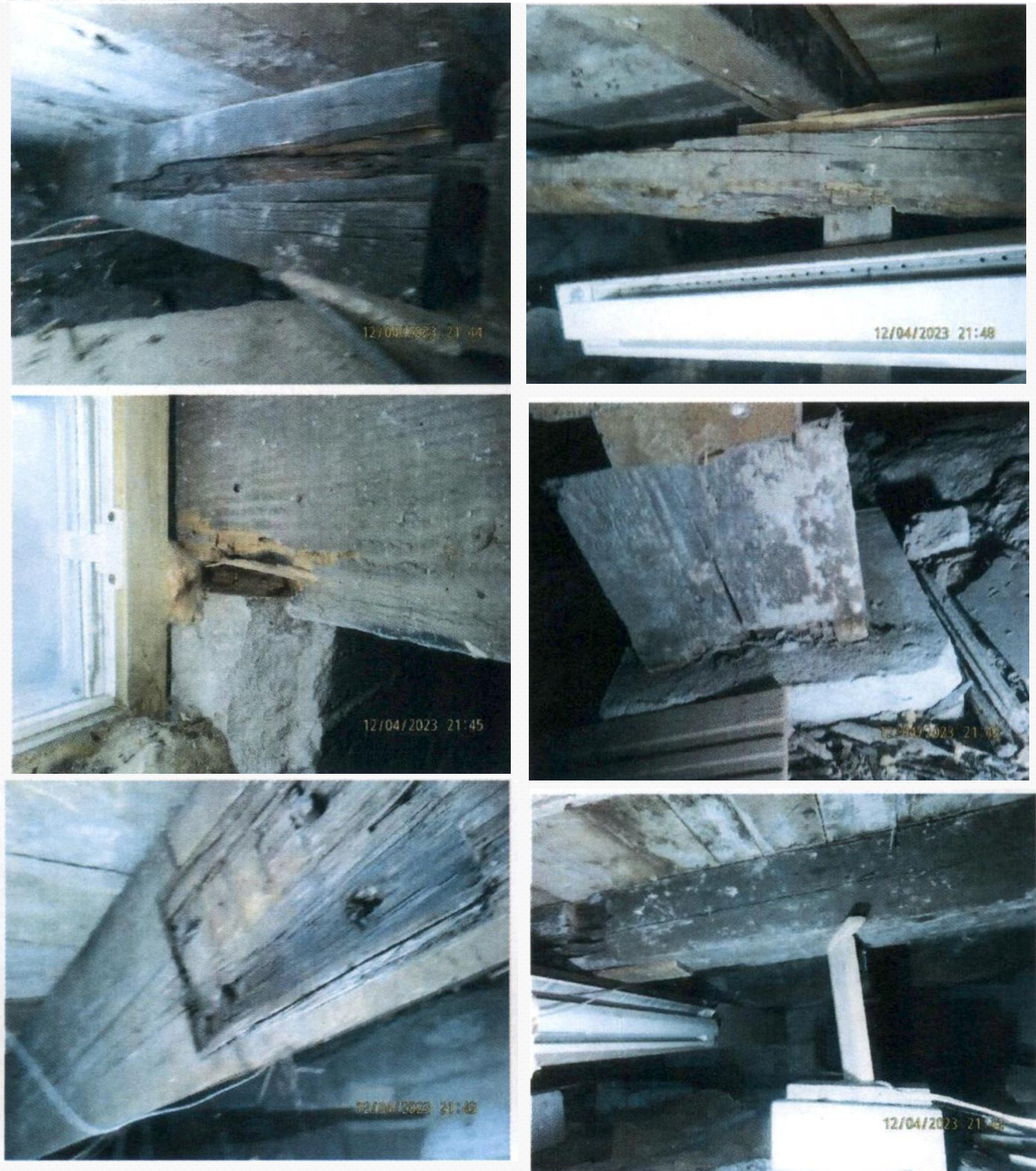
Structure sous la maison
