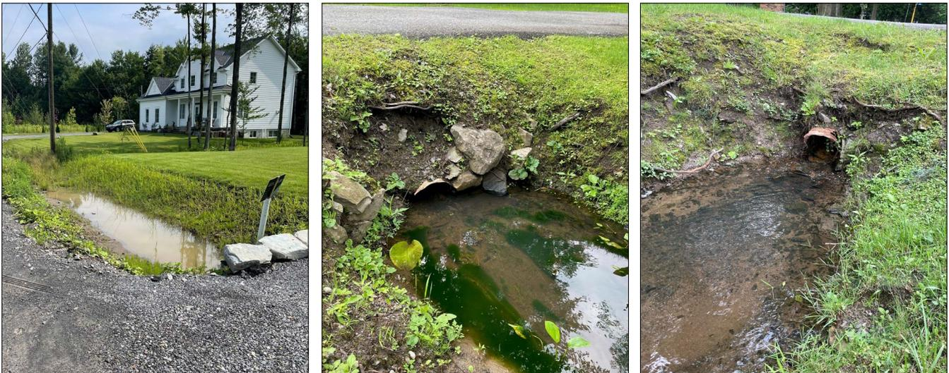
**Figure 5.1 Exemples d'absence de végétation ou de végétation inadéquate sur les talus d'un fossé**
