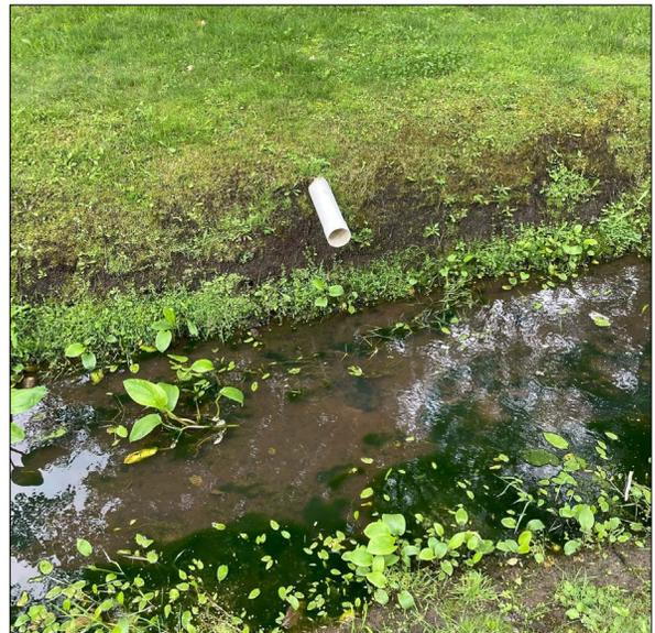
**Figure 5.4 Exemple de mauvais profilage d'un fossé**
