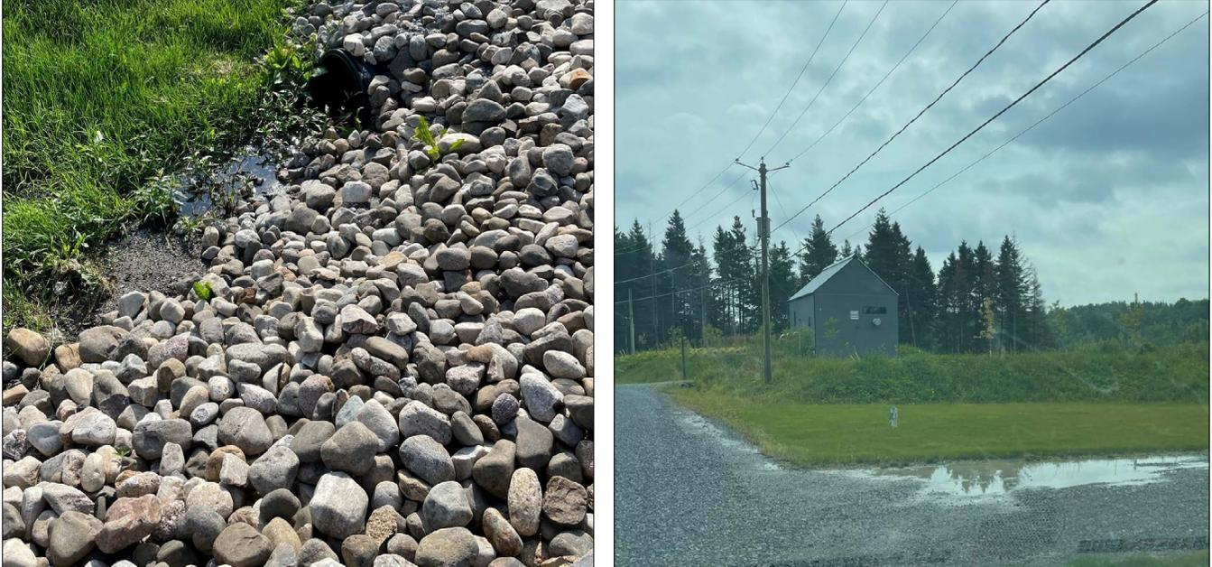
**Figure 5.3 Exemples d'obstruction d'un fossé par enrochement et remblai**
